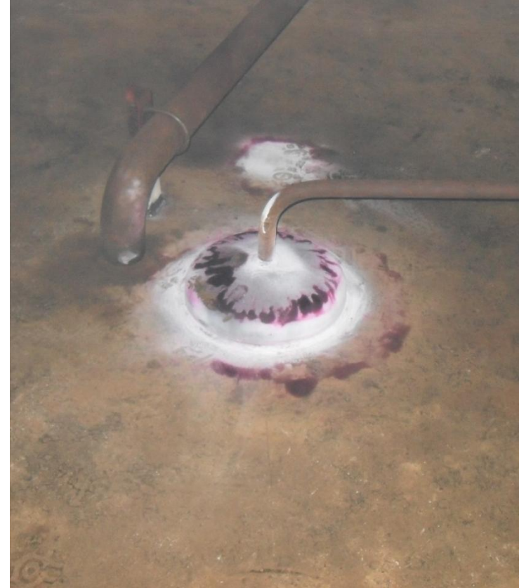
Messleitungsanschluss am Boden
